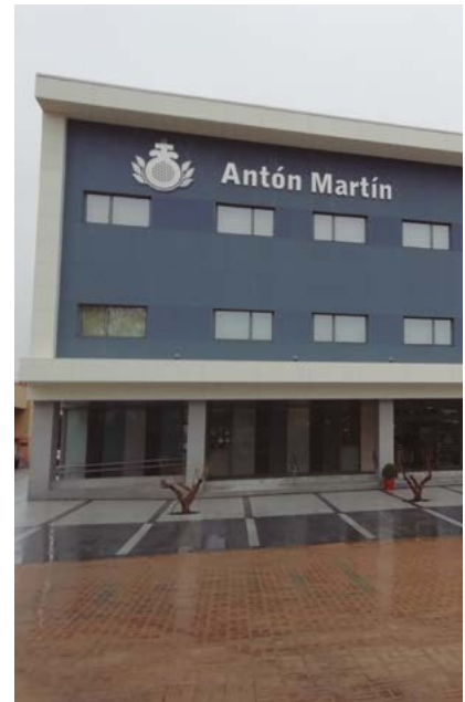
José M a Avendaño, vicario general de la Diócesis, bendijo el edificio.
